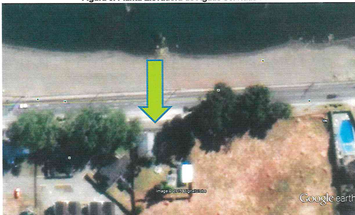
Figura 3. Planta Elevadora de Aguas Servidas Puerto Chico
